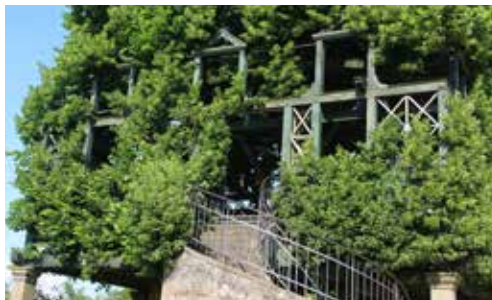
Das ganze Jahr über können Besucher die Tanzlinde Peesten besteigen. Ein aufwendig gebautes und unterhaltenes Gerüst macht dies möglich.
